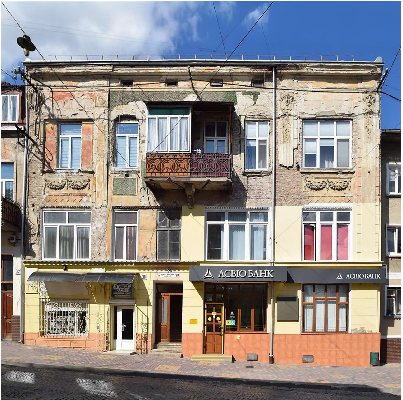
рис.12 – існуючий стан фасаду будинку №30 по вул. Степана Бандери
